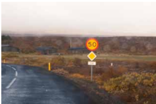
Staðsetning skilta of nálægt vegbrún
