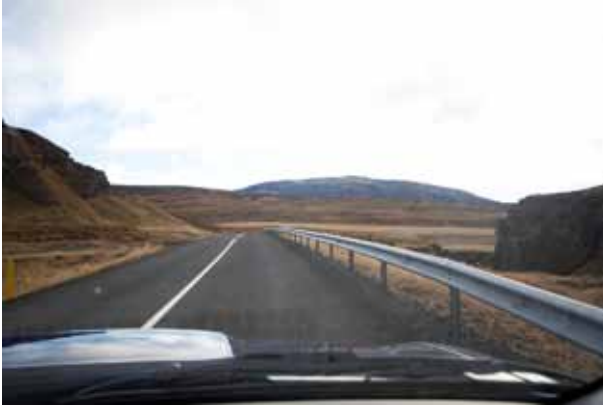
Vegrið í útbeygju, óvarðir stólpar
