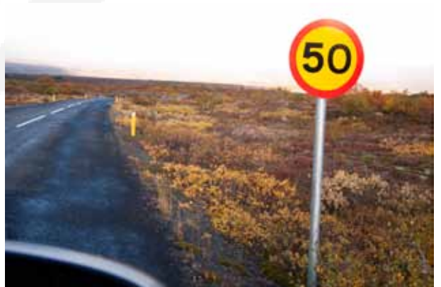
Staðsetning skilta of nálægt vegbrún
