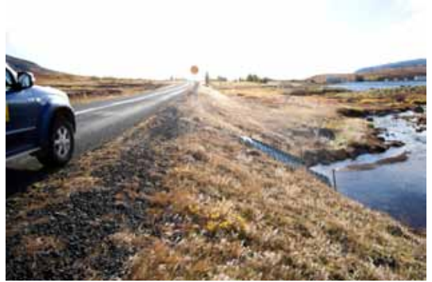
Staðsetning skilta og ræsi við vegbrún
