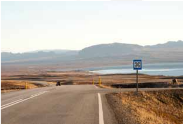
Blind aðkoma að útsýnisstað. Mjög hættulegt vegna útkeyrslu
